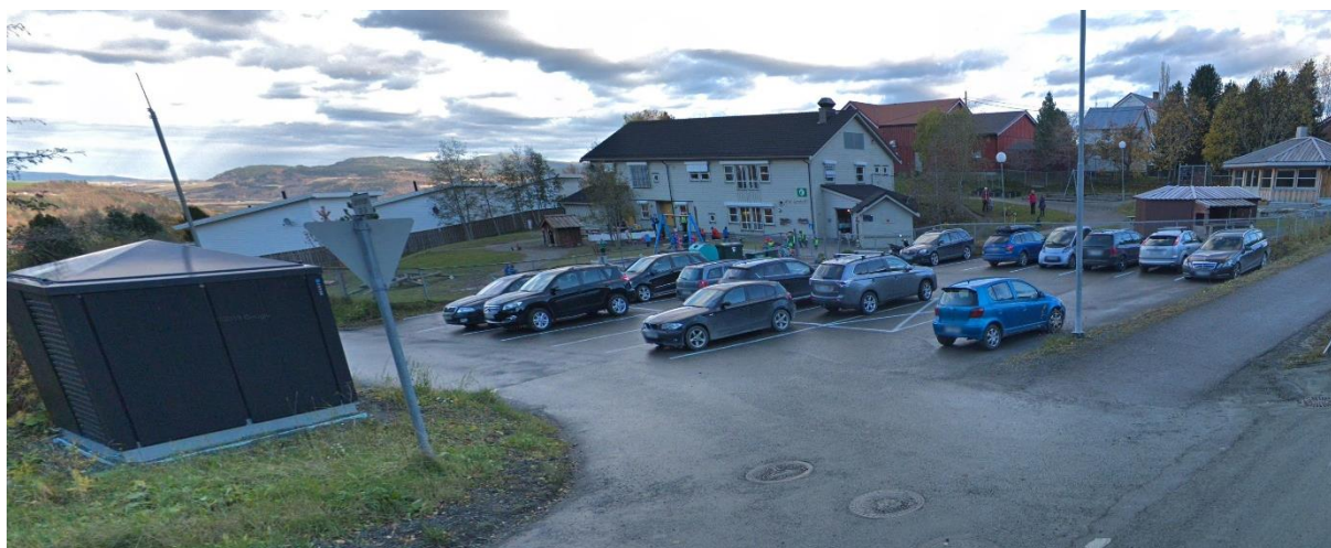
Bilde 17: Dagens innkjøring fra Løvsetvegen til Løvset Barnehage og p-plass.
